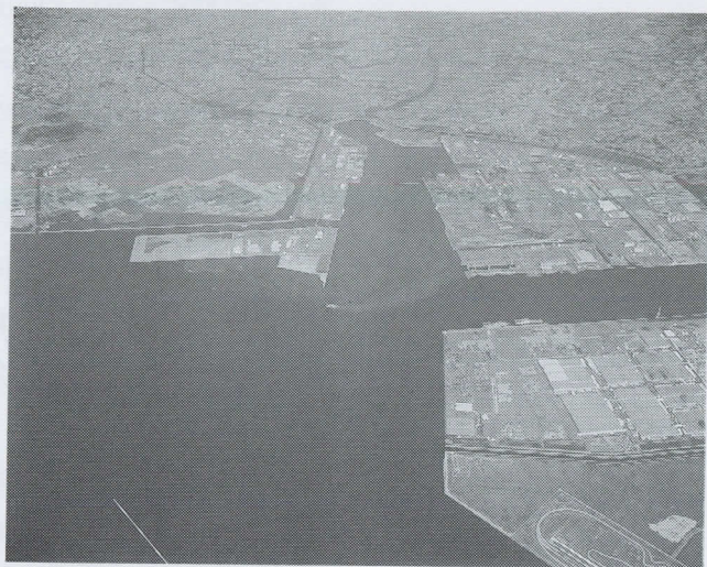
現在の豊橋港（平成6年）
